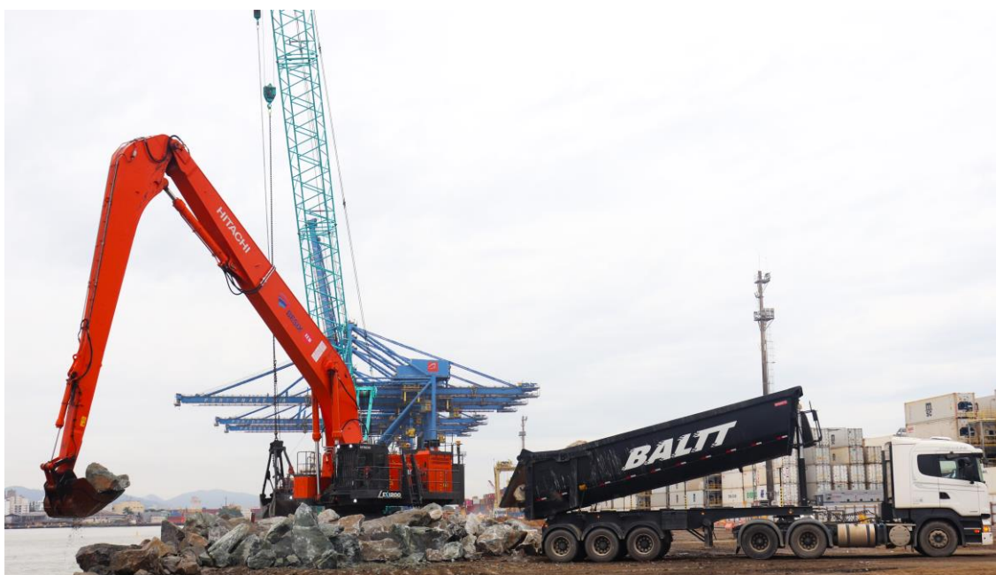
Escavadeira, caminhão e guindaste utilizados no enrocamento.
