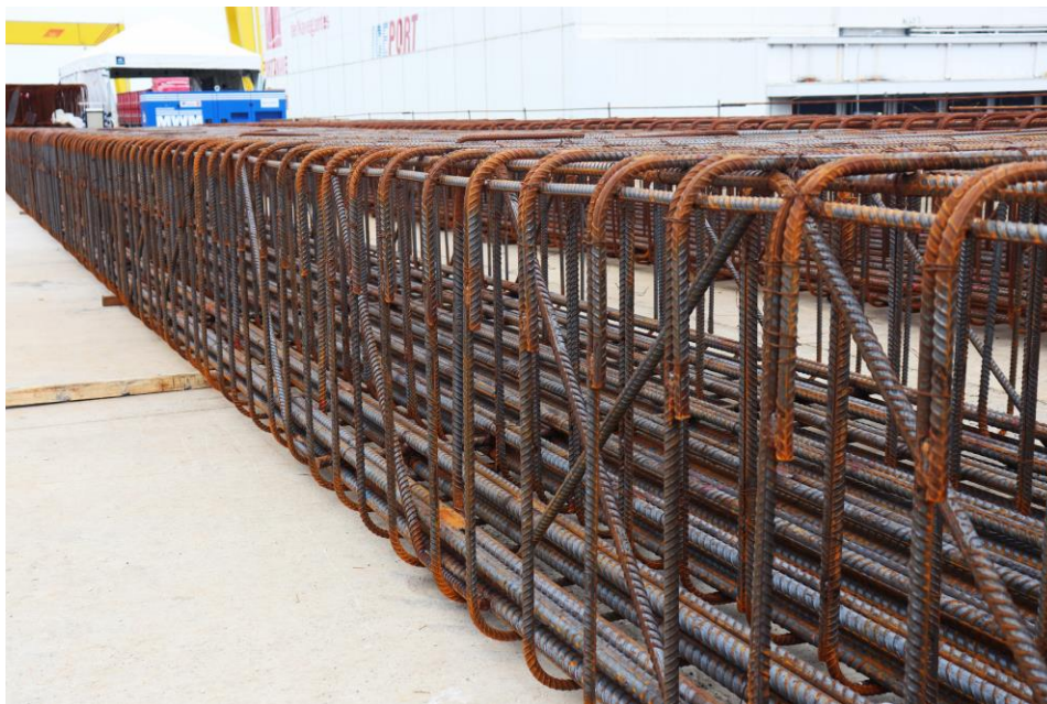
Gaiolas de armadura da parede diafragma.
