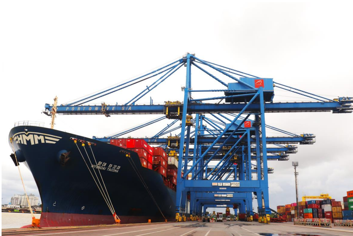
Lado oeste do cais em operação com cinco portêineres no navio.
