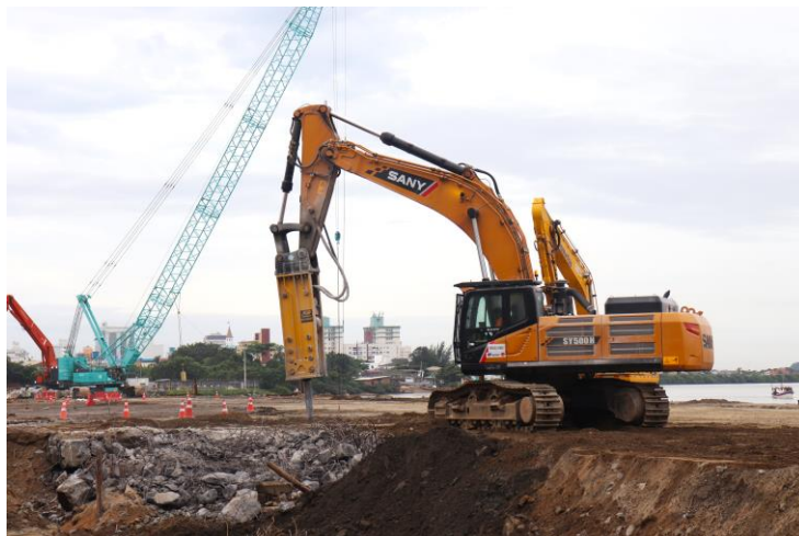
Demolição do cais.
