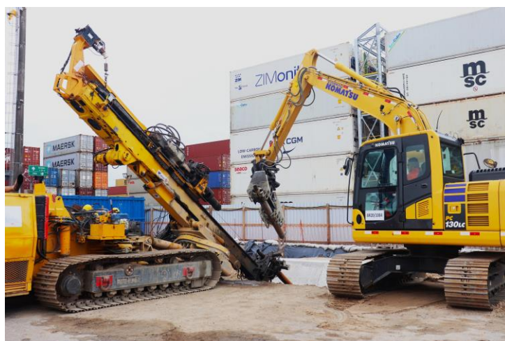
Teste dos tirantes, preenchidos com calda de cimento e fixados com cordoalhas de aço.
