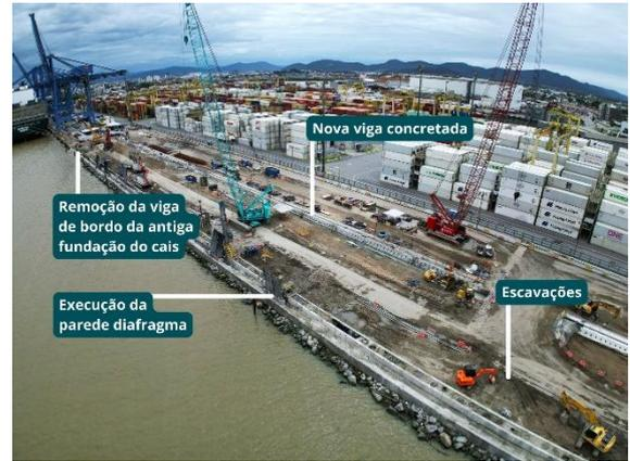
*Remoção da viga de bordo com o uso de fio diamantado*
