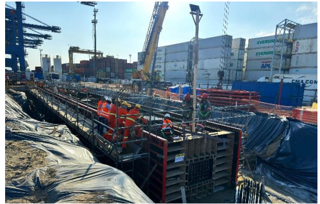
Profissionais da Besix-ECB realizam a nova fundação
