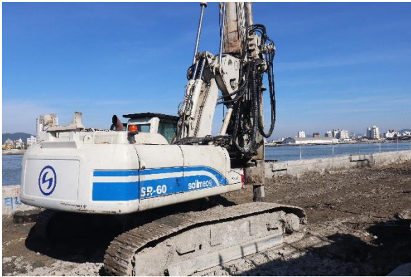
Remoção das estacas da antiga fundação
