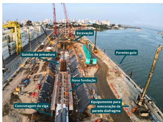
A parede diafragma está em andamento. Essa estrutura, com aproximadamente 60m de profundidade, conterá o solo e servirá de fundação de um dos trilhos que suportará os esforços dos guindastes *Ship to Shore* (STS) para movimentação de contêineres. Ela é construída entre o espaço das paredes-guias – que são estruturas temporárias para auxiliar a construção da parede diafragma – por meio da escavação, estruturação das ferragens e concretagem no próprio local.
