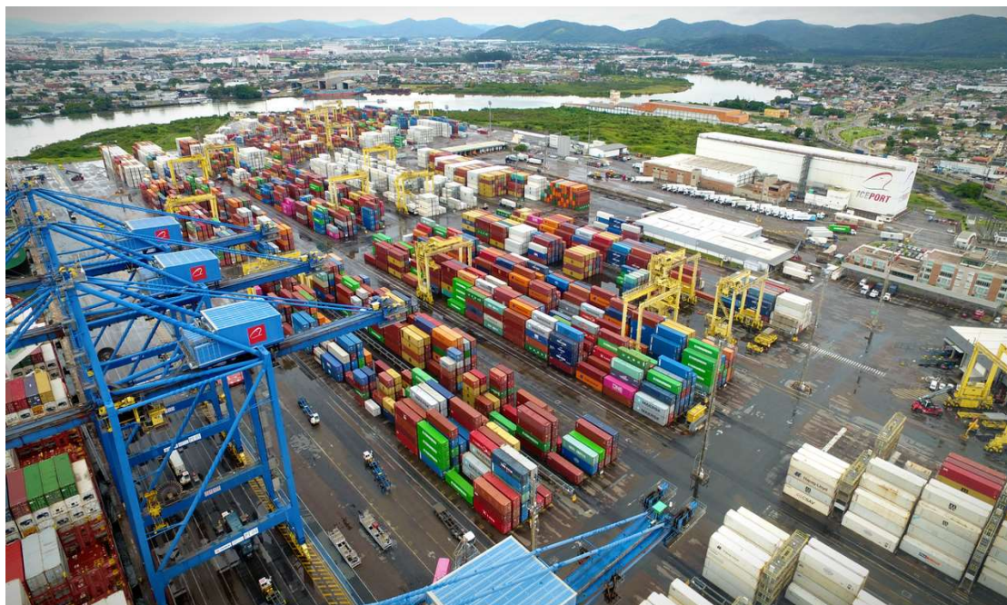
Figura 01 - Vista geral das instalações da Portonave S/A e Iceport S/A.
